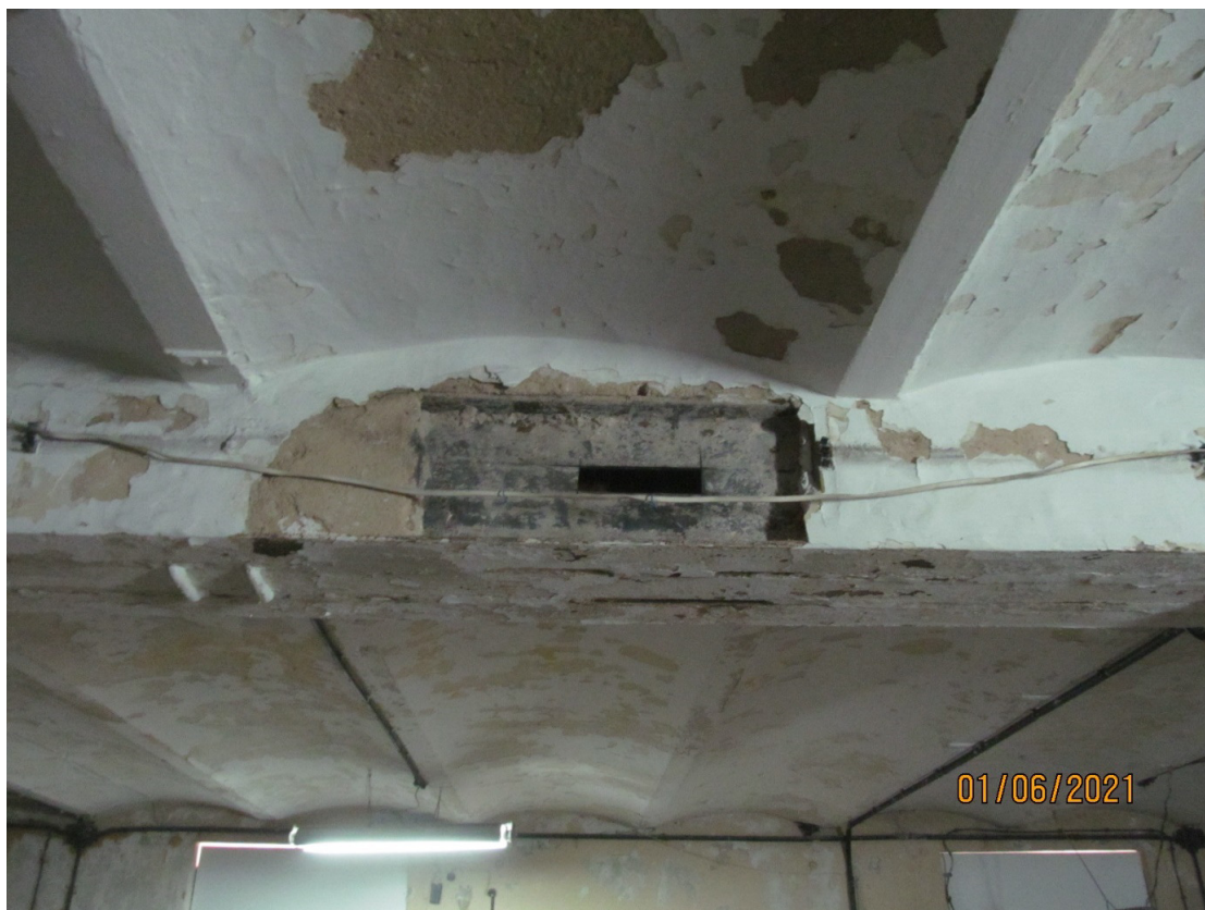
Zdj.5.7 Rama Ip. Widoczny wyspałdowany rygiel, odstąpięty w miejscu pobrania próbki do badań.
