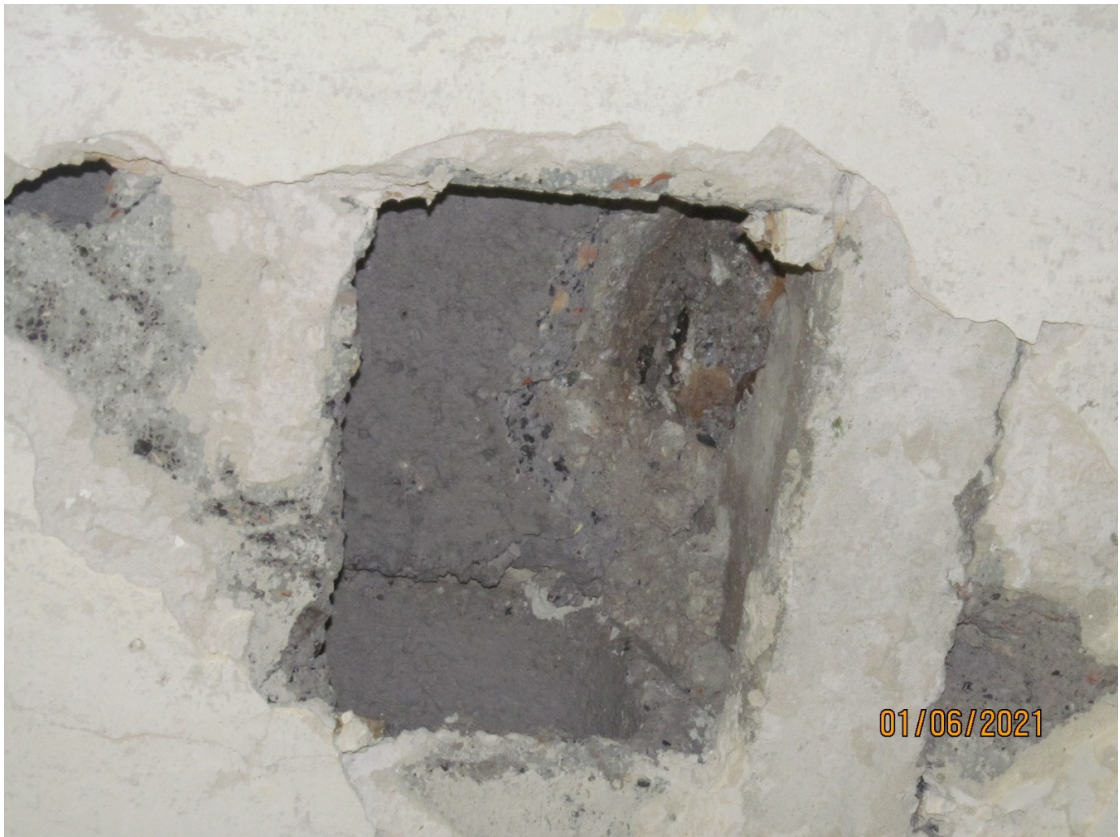
Zdj.5.4 Odkrywka stropu DMS. Widoczne żebra i powierzchnia górnej ścianki pustaka.
