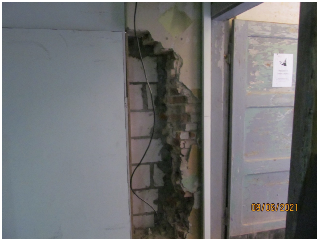
Zdj.5.14 Rozkuty i pozostawiony otwór okienny.
