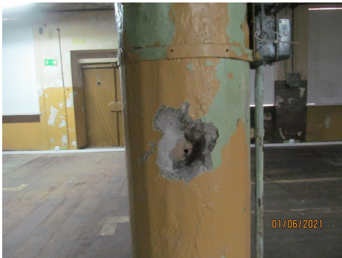
Zdj.5.8 Stupa rama w Ip. w miejscu odkrywki. Widoczne obetonowanie stupa żeliwnego.
