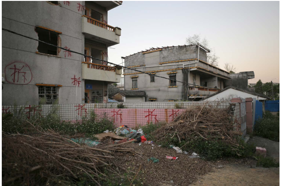
Budynki przeznaczone do wyburzenia, Shenzhen, Chiny, 2018
